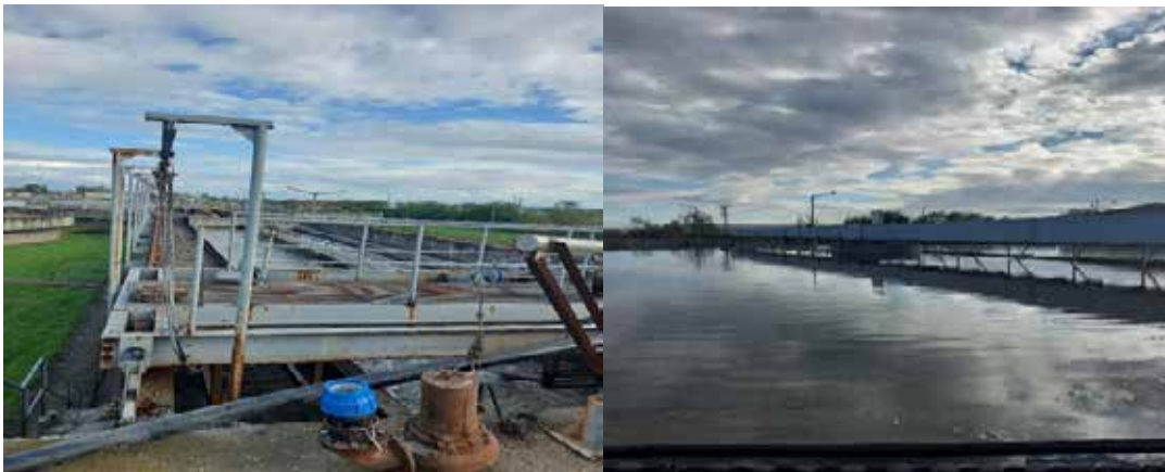
Şekil 1. Bafra Atıksu Arıtma Tesisi giriş ve çıkış yapıları
